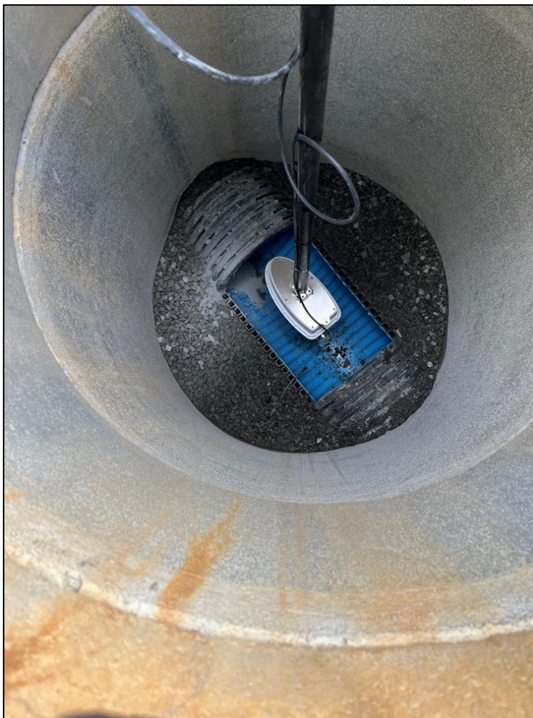
Figur 2-8. Foto av radarmåling som er installert over det midlertidige røret som er lagt for Mautubekken (bilde fra NIBIO, 19. april 2024).
