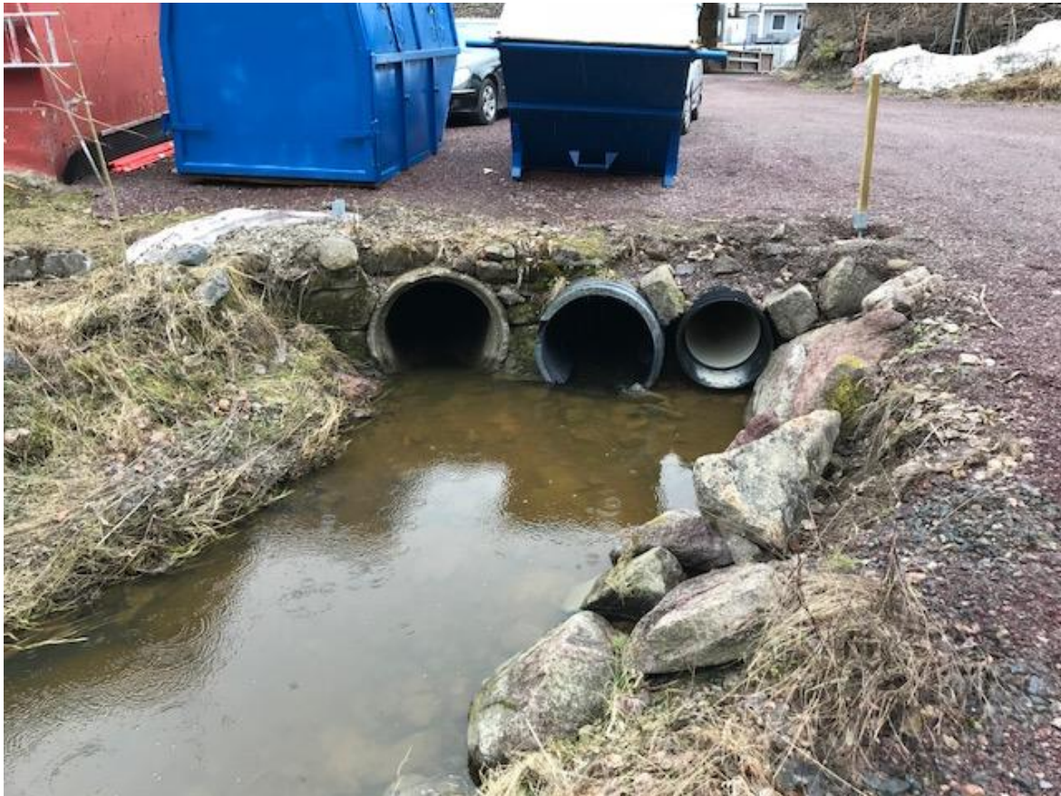
Figur 6-17: Innløp til bekkeløking under gårdsplass, bilde tatt ved befaring 24.04.18.
