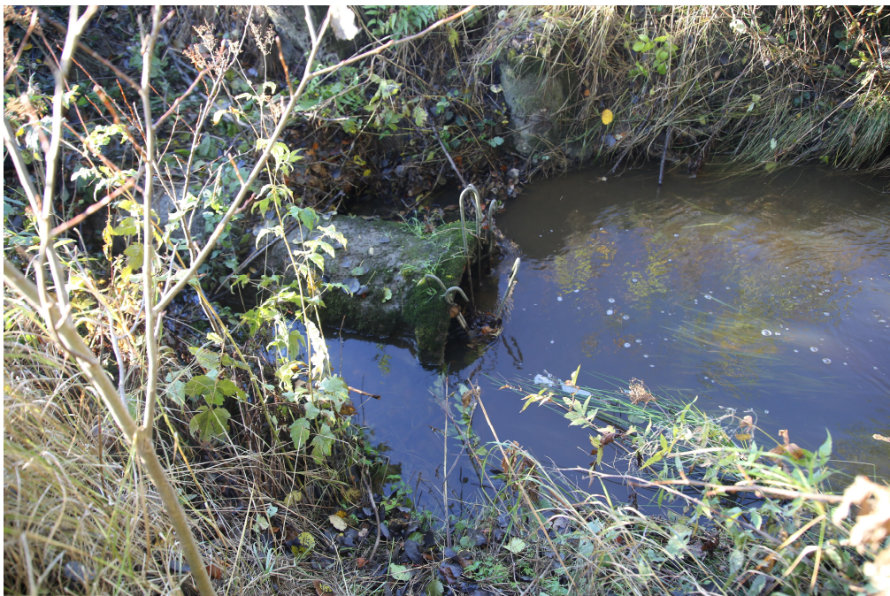
Figur 6-13: Bilde, eksisterende innløp bekkelukking Føskebekken
