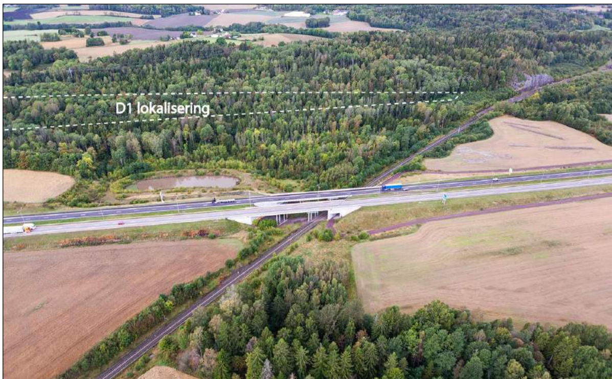
Figur 3-10: Området sett østfra, helikopterfoto (foto: Bane NOR, september 2017)
