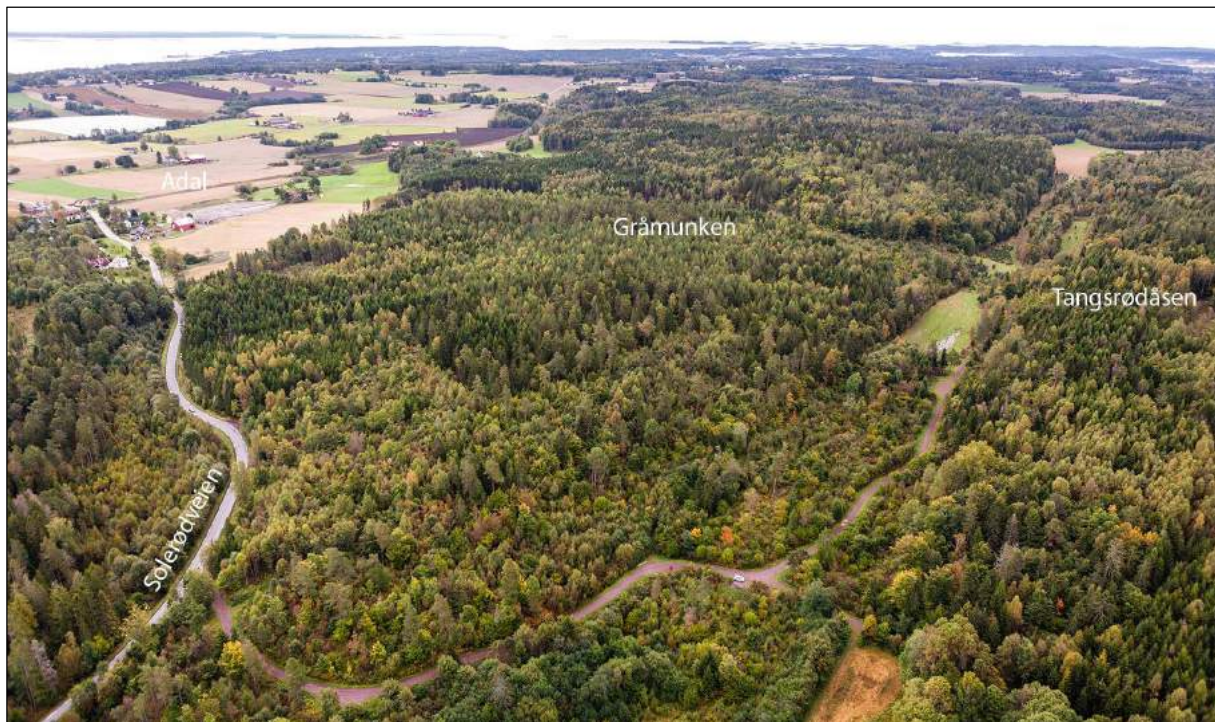
Figur 4-39: Helikopterbilde av dagens situasjon - delstrekning 6 – Tangsrødmarka med Gråmunken og Tangsrødåsen sett sørover. Dagens atkomstvei fra nord parallelt med Gråmunken vises. (foto: Bane NOR, september 2017)
