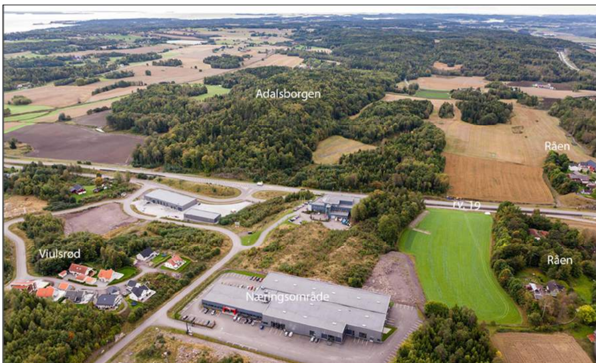
Figur 4-30: Helikopterbilde av dagens situasjon - delstrekning 5 - sett sørover mot rv. 19 og Adalsborgen (foto: Bane NOR, september 2017)
