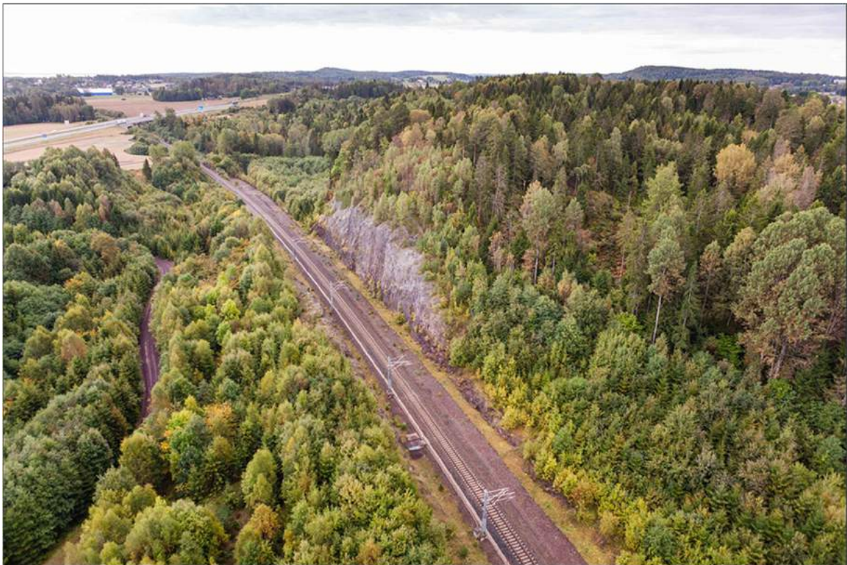
Figur 4-2: Helikopterbilde delstrekning 1 – bergskjæring sør for Tangentunnelen (foto: Bane NOR, september 2017)
