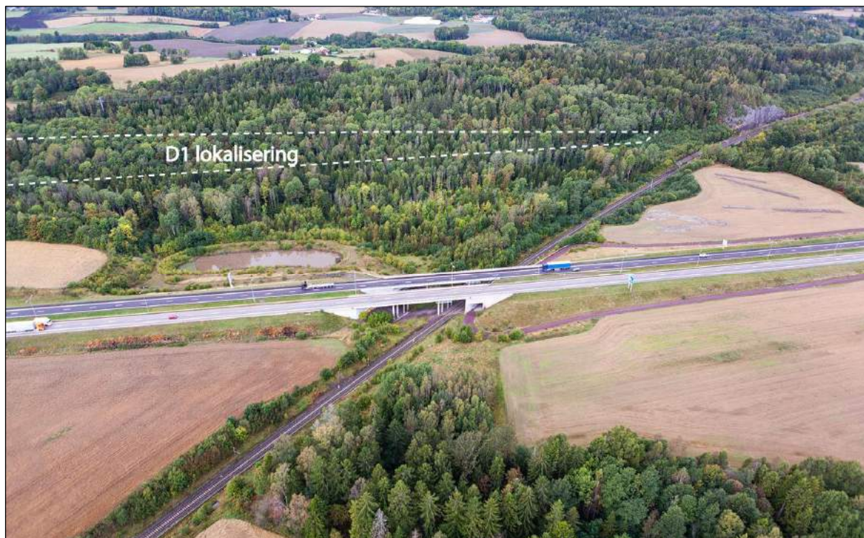
Figur 3-4: Området sett østfra, helikopterfoto (Foto: Bane NOR, september 2017)
