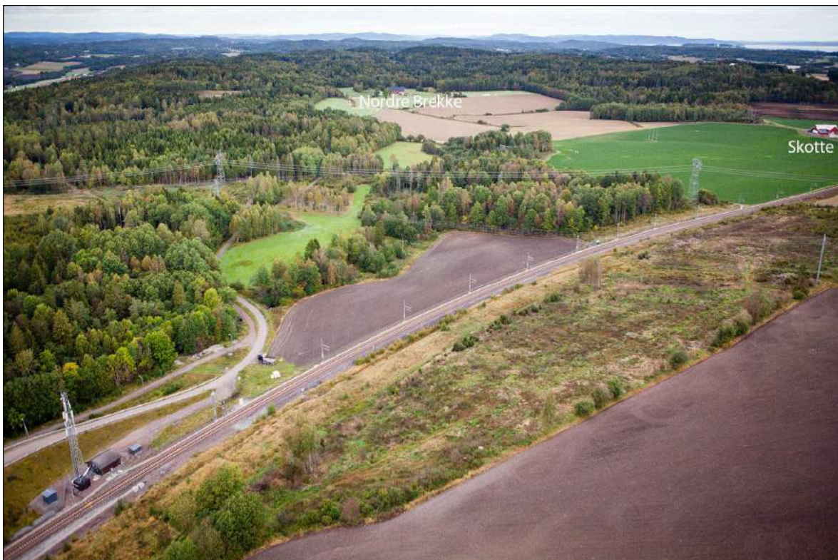
Figur 4-33: Helikopterbilde av dagens situasjon - delstrekning 7 – søndre del av området med dagens jernbane sett nordover (Foto Bane NOR, september 2017)
