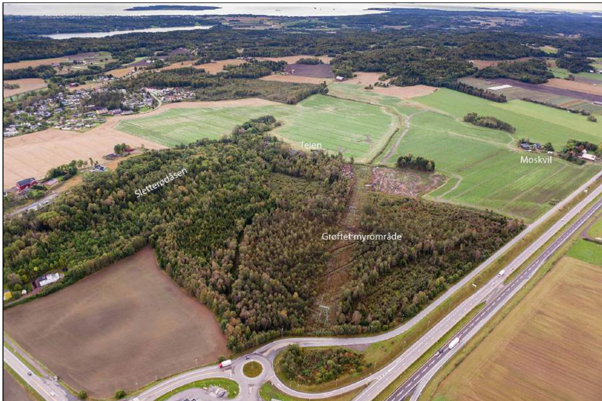
Figur 4-9: Helikopterbilde av dagens situasjon - delstrekning 3 - sett sørøstover fra Kopstadkrysset (Foto: Bane NOR, september 2017)
