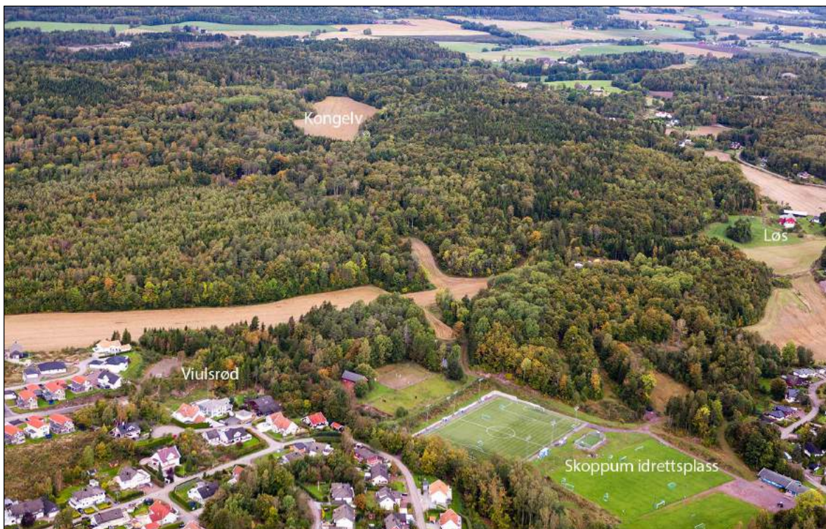
Figur 4-16: Helikopterbilde av dagens situasjon - delstrekning 4 - fra Skoppum sett vestover (Foto: Bane NOR, september 2017)
