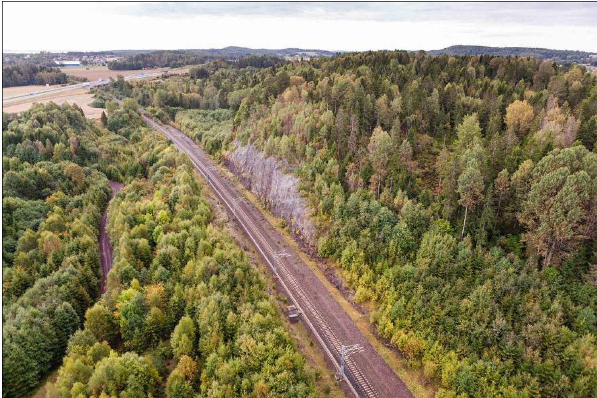
Figur 4-3: Helikopterbilde delstrekning 1 – bergskjæring sør for Tangentunnelen (Foto: Bane NOR, september 2017)
