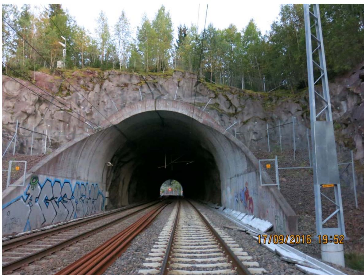
Figur 2-1: Eksisterende Tangentunnel, nordre portal
