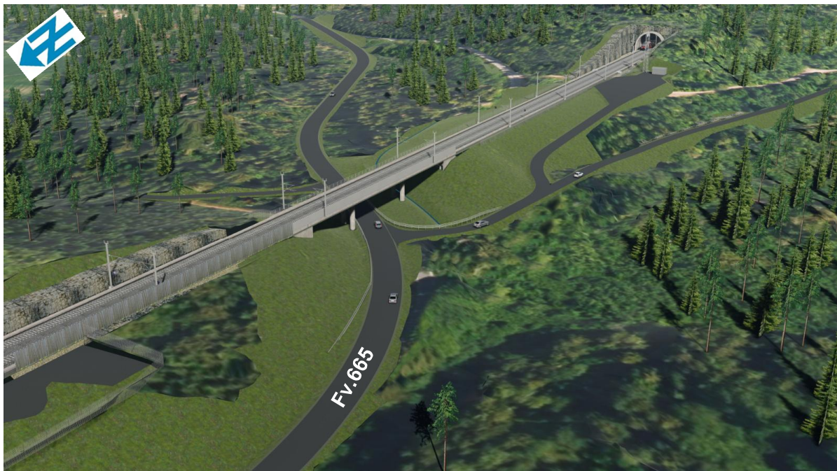
Figur 4-8: Ny fv.665 Solerødveien. Det er satt av plass til framtidig g/s-vei på høyre side av veien, sett mot sørøst
