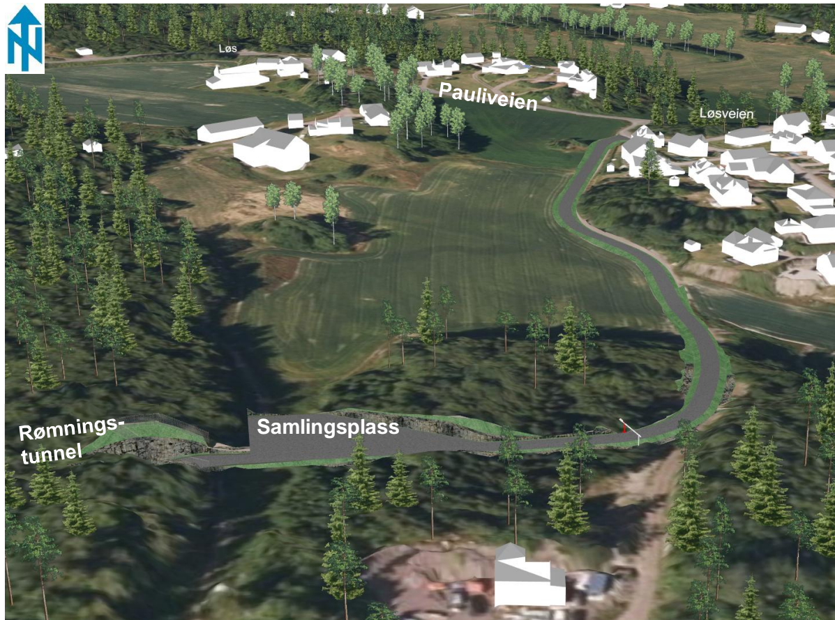
Figur 6-3: Samlingsplass Viulsrød nord, sett mot nord
