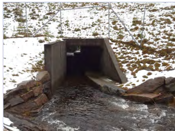
Figur 61: Eksempel på faunapassasje med amfibiegjerde og lavt viltgjerde til venstre og kombinert bekk i kulvert og småviltpassasje til høyre (foto: Multiconsult)
