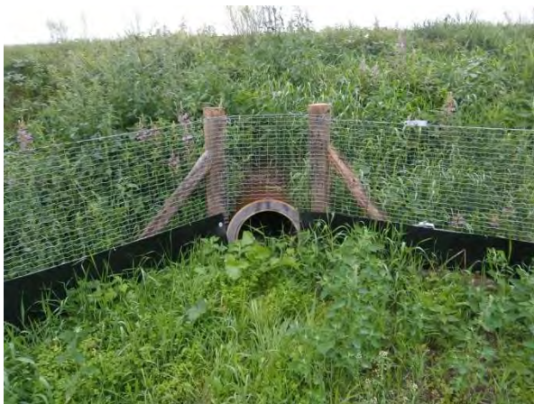
Figur 61: Eksempel på faunapassasje med amfibiegjerde og lavt viltgjerde til venstre og kombinert bekk i kulvert og småviltpassasje til høyre (foto: Multiconsult)
